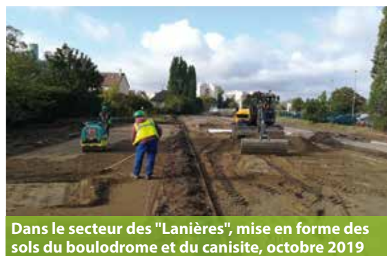
Début des travaux fin avril 2019, dans le secteur du « Plateau »
